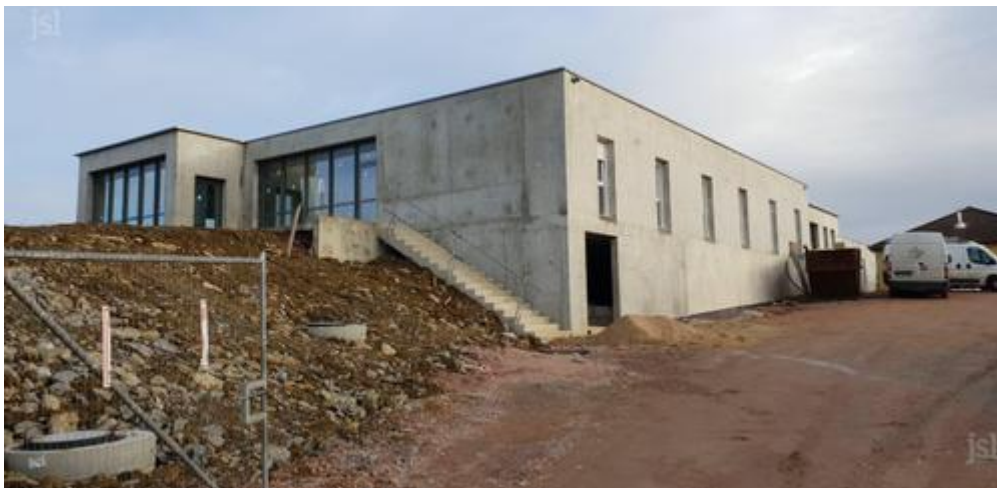
Le gros œuvre est désormais terminé. Photos JSL /Laurence RIVAT
