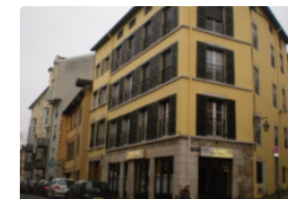
MACON 14 logements + 5 diffus
