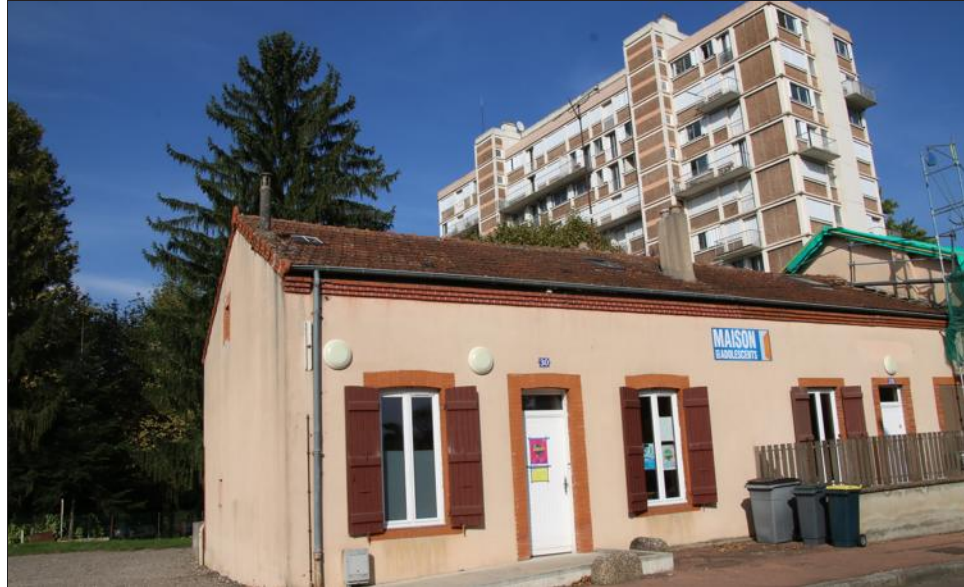
■ La Maison des adolescents est située entre la Maison de quartier des Aubépins et le lycée Saint-Charles. Photo Christophe ROULLIAUD
